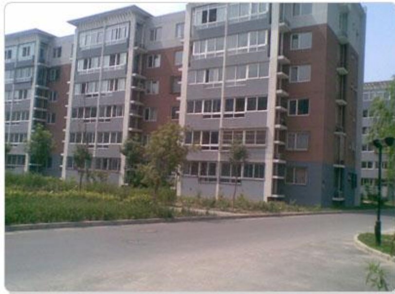
图一：北京三合庄工业园住宅小区
